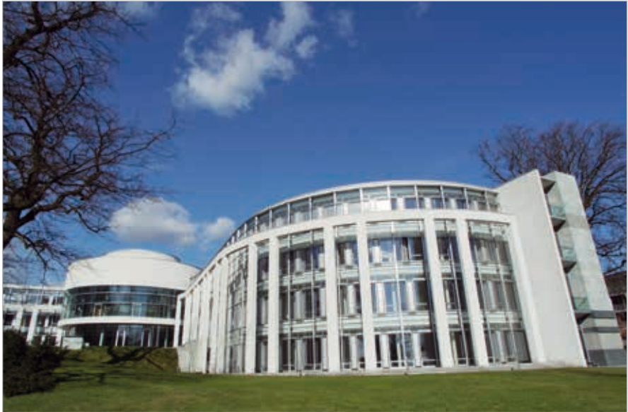
Vue extérieure de la salle d'audience et de l'aile sud du bâtiment principal
